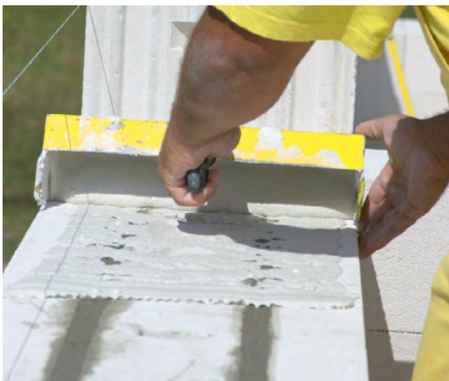
После армирования кладки можно сразу приступить к сооружению следующего ряда, который будет находиться непосредственно под оконным проёмом. При этом следите, чтобы блоки верхнего ряда были смещены относительно блоков нижнего ряда не менее, чем на 115 мм.
