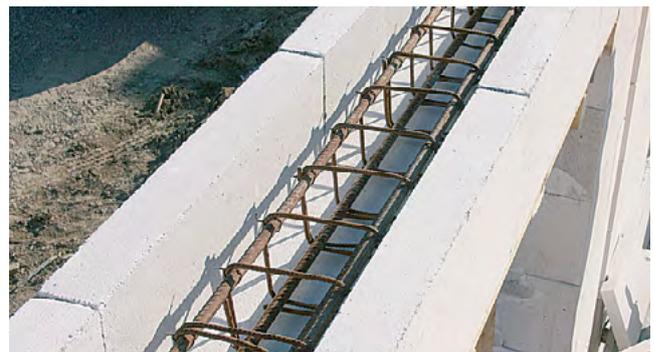
Уложите ряд из U-блоков при помощи тонкошовного раствора, устраните неровности. Внутри U-блоков разместите пространственный арматурный каркас. Пространственный каркас для армопояса назначается конструктивно, в соответствии со следующими рекомендациями. Используйте арматуру А400, А500 диаметром 10–14 мм с хомутами А 240 (А-I) диаметром 6 мм, с шагом 200 мм. Продольную арматуру каркаса последовательно укладывайте с нахлестом прутков на величину не менее 1 м.
