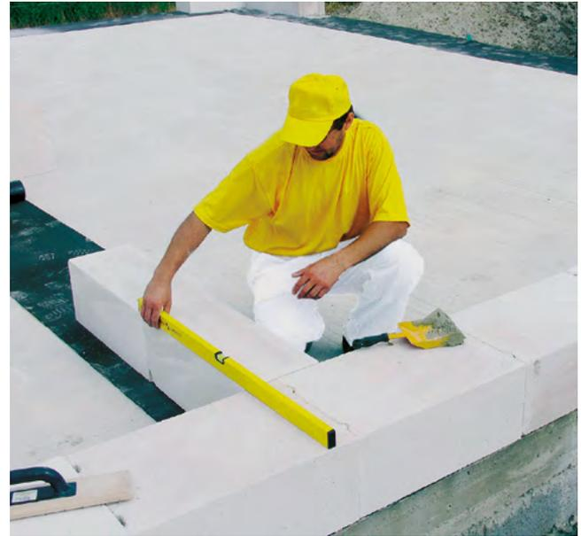
Укладывайте первый ряд на цементно-песчаный раствор, чтобы обеспечить жёсткость всей стеновой конструкции.
