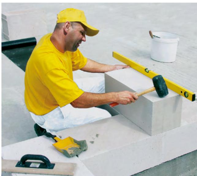
Начиная со второго ряда кладки наносите тонкошовный раствор на горизонтальную и вертикальную поверхности блоков, используя кельму. Раствор распределяйте равномерно, не допускайте разрывов в слое, соблюдайте требуемую толщину растворного шва. Соблюдайте плашковую перевязку блоков.
