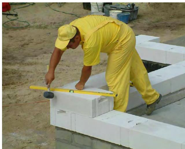
После установки угловых блоков растяните между ними шнур-причалку, как это делалось при укладке первого ряда, и заполните блоками очередной ряд.
