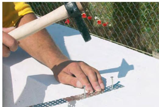
Второй конец связи закладывайте в растворный шов перегородочной кладки, на ту же глубину.
