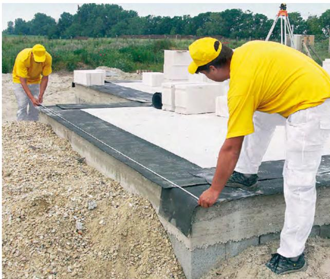
Не пренебрегайте отсечной гидроизоляцией, даже если выполнена гидроизоляция конструкции самого бетонного фундамента. Менее плотный материал, газобетон, всё равно будет впитывать эксплуатационную влагу из более плотного, бетона. Чтобы повысить срок службы газобетонных стен, следует всегда предусматривать отсечную гидроизоляцию между бетонным фундаментом и кладкой.
