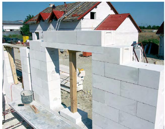
Блоки фиксируйте на готовой перемычке и соединяйте друг с другом при помощи раствора для тонкошовной кладки.
