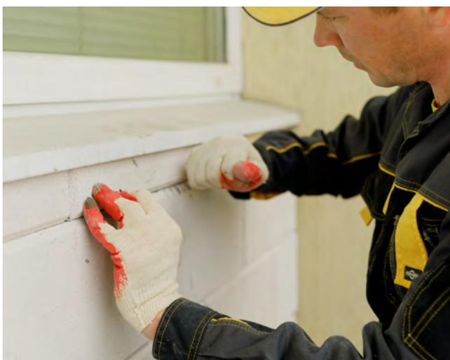
Если используется полиуретановая клей-пена, то наносите её на тыльную поверхность плитки, вдоль её длинной стороны, полосами (валиками) размером 10–15 мм на расстоянии 15–20 мм
