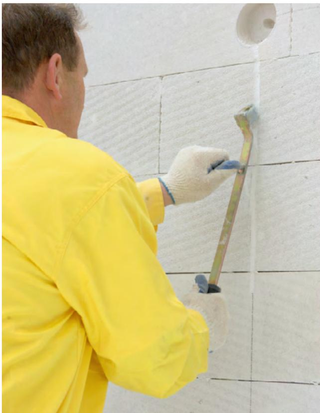
Отверстия для электроустановочных изделий (розеток, выключателей и пр.) высверливайте безударной низкооборотной дрелью с нужной насадкой.
