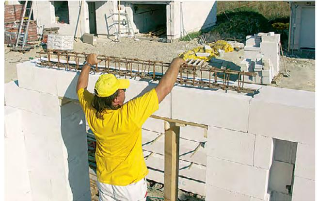
Между внешней стенкой U-блоков и арматурным каркасом рекомендуется проложить вкладыш из утеплителя, толщиной не менее 30 мм. Это повысит теплозащитные свойства перемычки. Вкладыш лучше выполнять из экструдированного пенополистирола.
