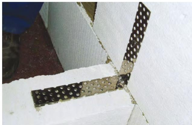
Если есть необходимость установить перегородку по окончании возведения несущей стены, то гибкие связи крепите к вертикальной части этой стены дюбелями по газобетону.
