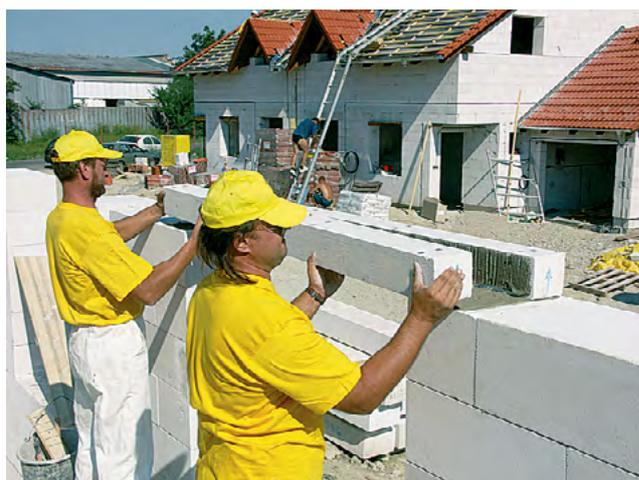
Неровности на поверхности перемычек выровняйте рубанком и шлифовальной доской. После этого щёткой очищайте поверхность от пыли.
