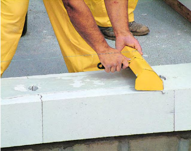
Распределяйте раствор равномерно по всей горизонтальной поверхности кладки, на которую вы будете устанавливать блок.
