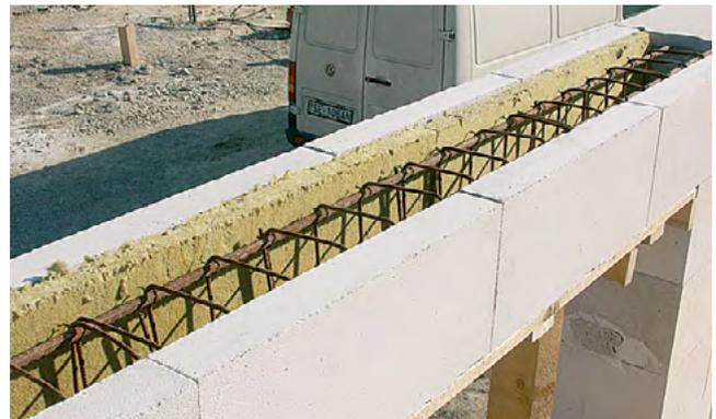
В жаркую погоду перед началом бетонирования смочите конструкцию водой.
