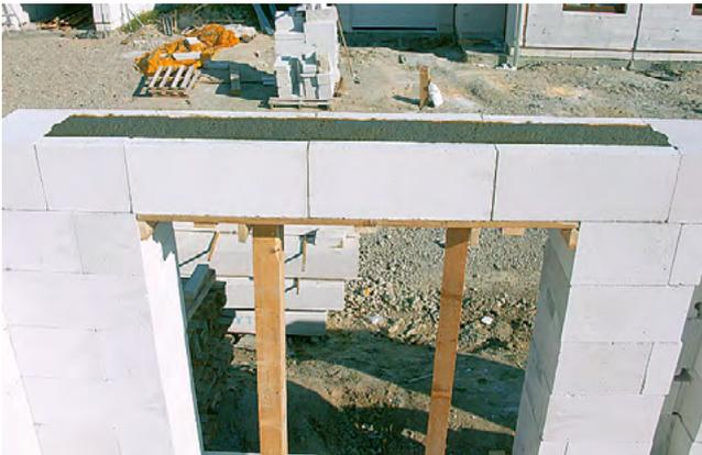
При этом армопояс под перекрытием или конструкцией крыши, а также монолитное или сборно-монолитное перекрытие могут выступать в качестве перемычки проема, если сечение и армирование перекрытия/армопояса воспринимают нагрузку от конструкций выше.
