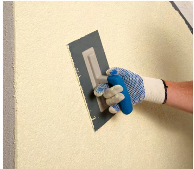
Перед нанесением штукатурки устраните недочёты кладки: незаполненные раствором швы и сколы заделайте ремонтной смесью из раствора и газобетонной пыли (1:1), потёки раствора и бетона срежьте и это место отшлифуйте, пыль удалите.
