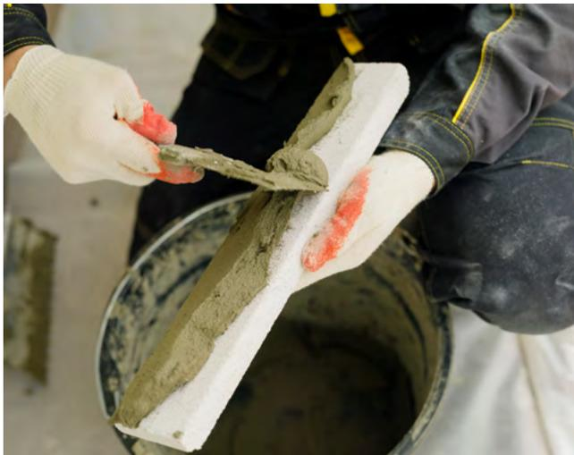
Затем нанесите клеевой раствор на облицовываемую поверхность зубчатым шпателем.
