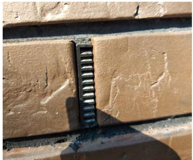
вдоль нижнего и верхнего края поэтажной кладки. Дополнительные отверстия оставляйте под и над оконными проёмами, над дверными проёмами.
