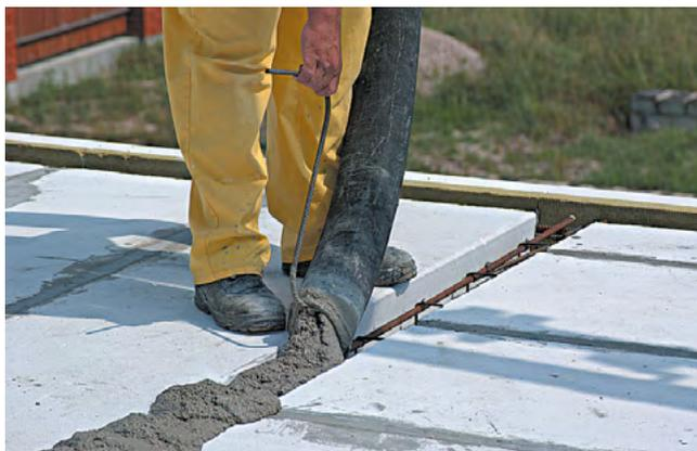
Перед бетонированием очистите поверхность от мусора, грязи и пыли, а также увлажните её в жаркую погоду. Иначе блоки могут не схватиться с бетоном. Арматура также должна быть очищена от грязи, пыли и коррозии.
