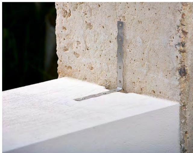
Если в здании внутренняя стена выполняется не из газобетона, а из другого, более плотного каменного материала (кирпич, пескобетон и пр.), то соединяйте её с несущей стеной из газобетона при помощи гибких связей, с обязательным устройством армопояса по этим стенам.
