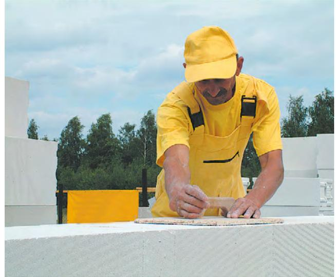
Для шлифовки используйте рубанок и/или шлифовальную доску — в зависимости от величины неровностей. Пыль, оставшуюся после шлифовки, удаляйте щёткой.
