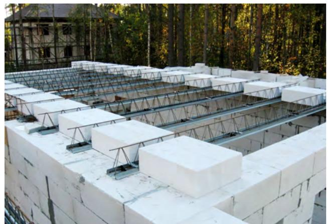
При необходимости распиливайте блоки, чтобы обеспечить их необходимые размеры. Распиленный блок укладывайте только крайним к стене, с минимальной зоной опирания на неё —  $20$  мм.
