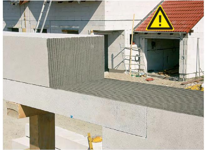
Корректируйте установку блоков резиновой киянкой. Для окончательного выравнивания шлифуйте поверхность блоков и удаляйте щёткой пыль.
