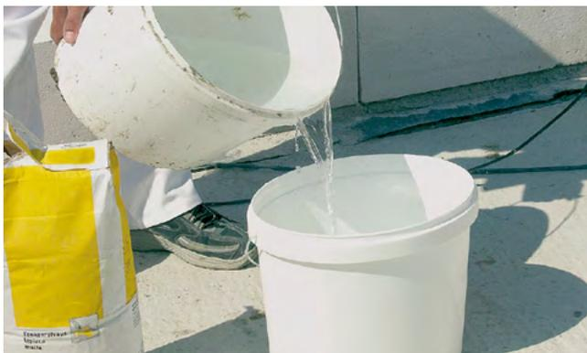
Рекомендуется затворить водой сразу весь мешок сухой смеси. Этого количества смеси хватает для возведения примерно 1,4 м<sup>3</sup> кладки газобетонных блоков.
