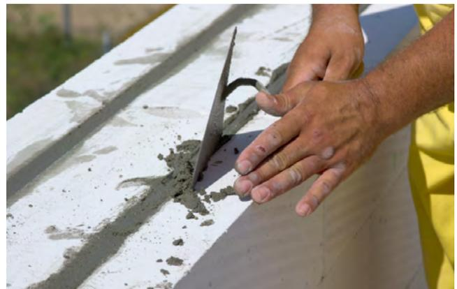
Пыль, которая образовалась после устройства штроб, удаляйте щёткой, чтобы улучшить сцепление раствора с блоками.
