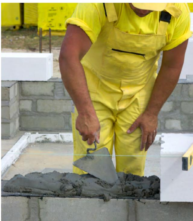
Кладку первого ряда стен начинайте с установки блоков в каждом углу здания. Предварительно выстройте контур стен, согласно проекту.
