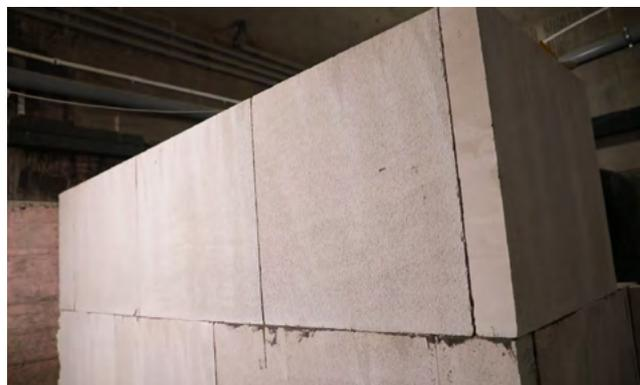
Укладывайте плиты с плашковой перевязкой глубиной не менее 150 мм.
