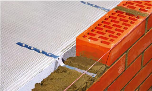
Один конец гибких связей (сетки) размещайте в швах между газобетонными блоками при сооружении несущей стены. Другой край заводите в соответствующий шов кирпичной кладки при возведении облицовки.
