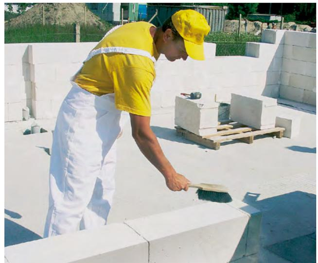
После кладочных работ на газобетонной стене могут остаться сколы. Заделывайте их ремонтной смесью тонкошовного раствора и пыли, оставшейся после распиливания блоков, в пропорции 1:1. При добавлении пыли раствор становится более густым и не приводит к появлению подтёков и наплывов. Если применять для заделки только раствор, либо раствор с пылью, добавленной
