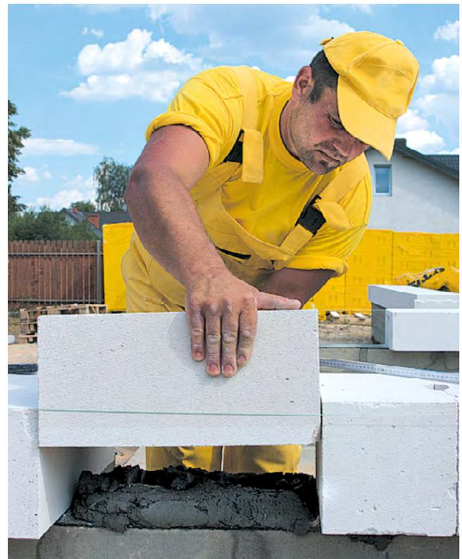
Вертикальные швы выполняйте с помощью раствора для тонкошовной кладки в сочетании с кельмой. При этом постоянно проверяйте, совпадают ли уровни соединяемых стен по горизонтали.
