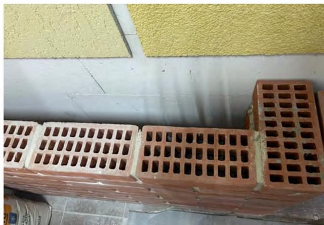
Кирпичную кладку опирайте либо на железобетонный фундамент, либо на консольный вынос (полку) из железобетона, устроенный по периметру железобетонного фундамента.
