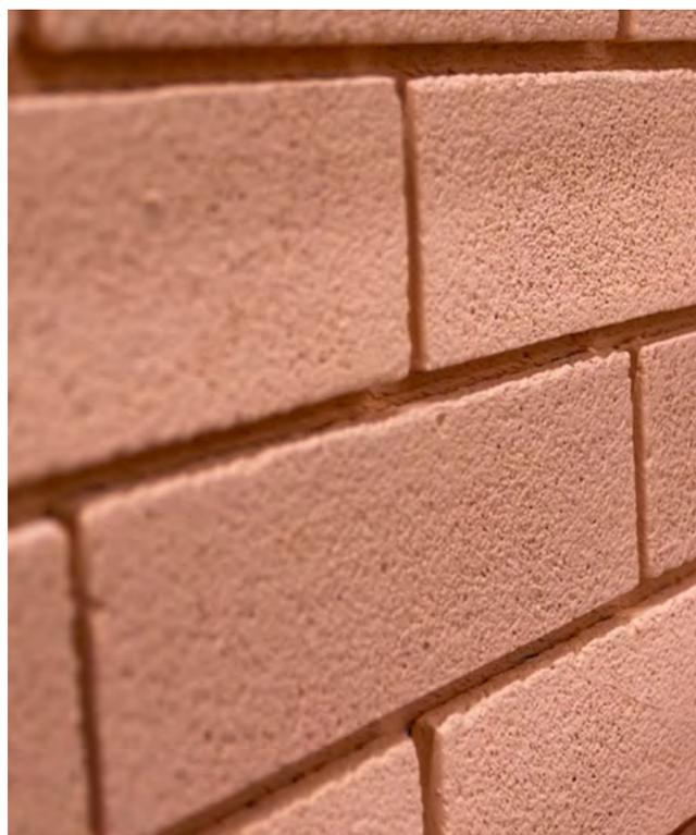
При монтаже плитки Decor заполняйте швы затирочным составом. Ширина шва между плитками должна составлять 10–12 мм.
