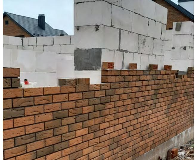
Обеспечьте возможность притока и вытяжки воздуха из зазора между стеной и облицовкой, а также возможность отвода конденсата из зазора, чтобы обеспечить продолжительный срок службы фасадной конструкции. Для этого при сооружении облицовочной кладки оставляйте в вертикальных швах отверстия (продухи), не заполненные раствором. Другой, более технологичный вариант — вставляйте в вертикальные швы специальные вентиляционные короба с воздушным лабиринтом, выполненные из полимерного материала.
