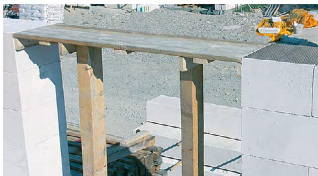
Минимальная глубина опирания перемычки на кладку с каждой стороны от проёма — не менее 250 мм. Устанавливайте U-блоки широкой стенкой в сторону улицы.
