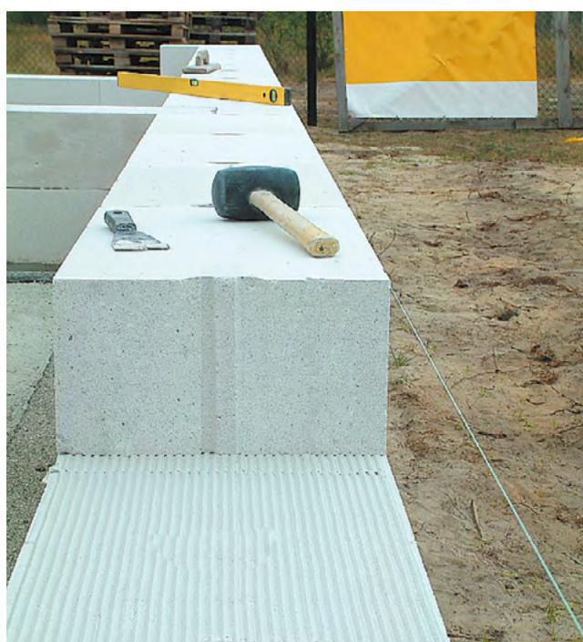
Для нанесения раствора используйте только специализированную зубчатую кельму ISTKULT, ширина которой соответствует толщине применяемых блоков.
