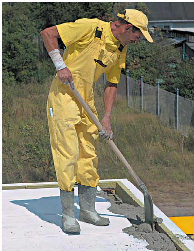
При бетонировании в несколько этапов выполняйте работы захватками (участками) шириной не менее 620 мм. Бетонируйте захватку за одну рабочую смену.
