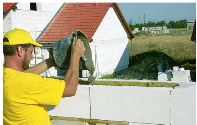
Уплотните бетон вручную или с помощью электроинструмента. Поверхность залитого бетона выровняйте.
