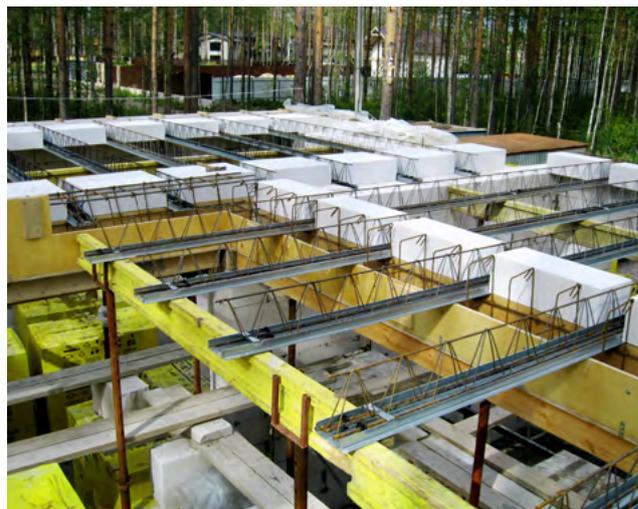
А500. Нижние ряды арматуры соединяйте прутьями диаметром 12 мм, верхние — прутьями диаметром 8 мм.
