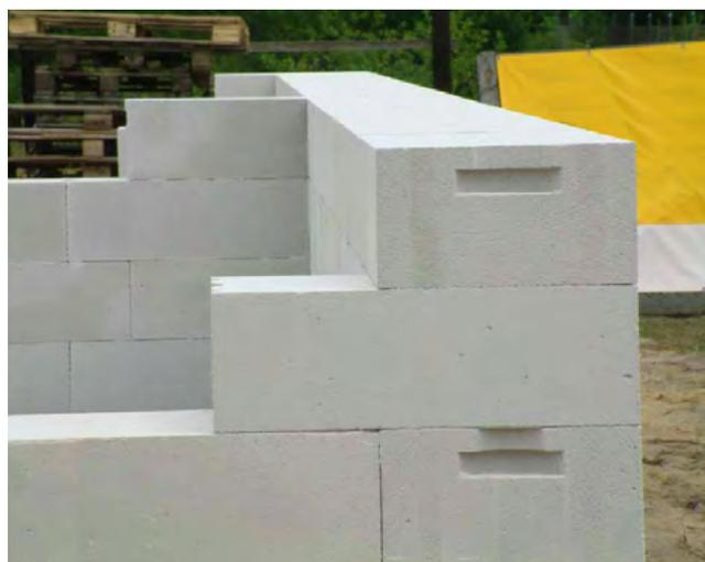
В стенах из блоков высотой до 250 мм величина продольной (плашковой) перевязки должна быть не менее 0,4 значения высоты блока, то есть не менее 100 мм. В стенах из блоков высотой более 250 мм величина перевязки должна быть не менее 100 мм и не менее 0,2 значения высоты блока.
