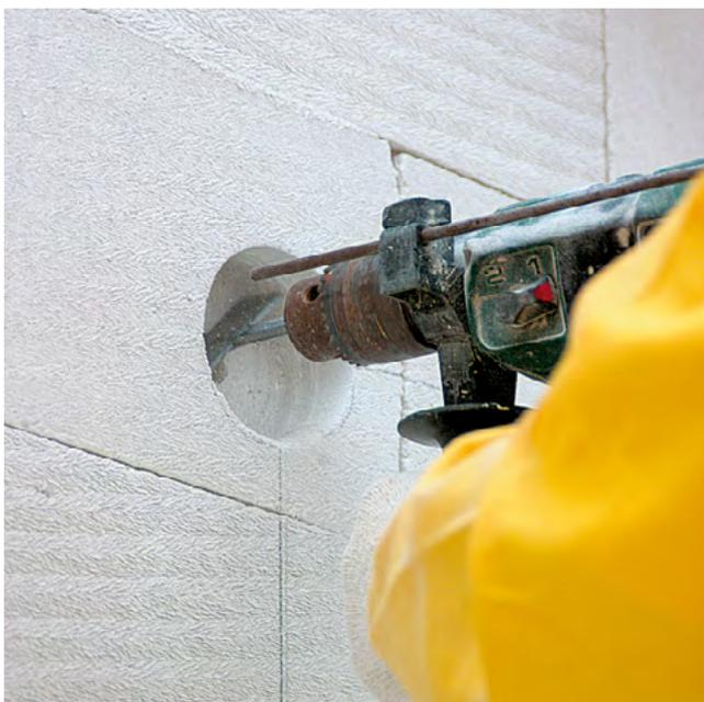
При подготовке ниши, например, для канализационного стояка, сначала отметьте на блоках размеры выреза. Затем в нужных местах сделайте
