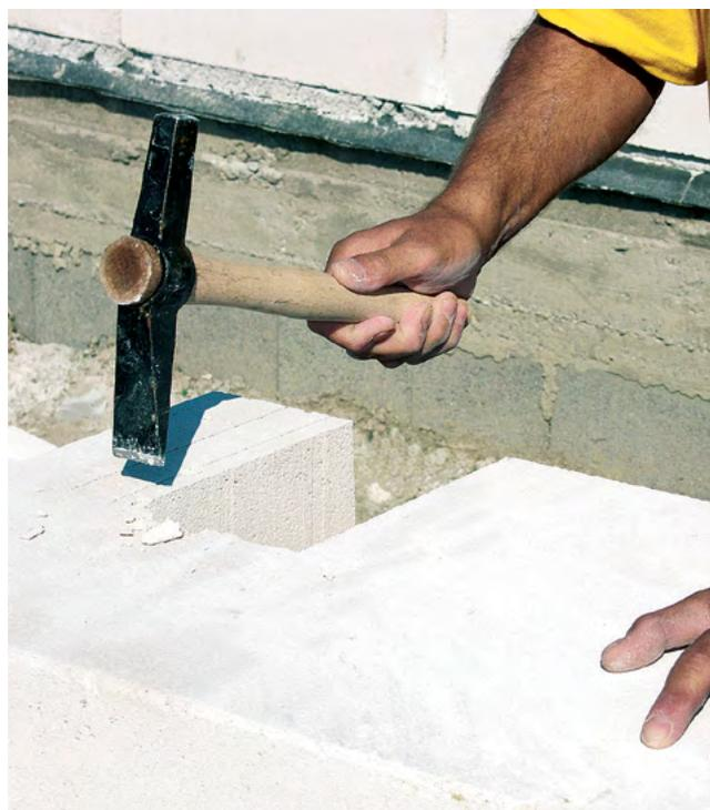
При создании ниш в наружных стенах ориентируйтесь на рекомендации по устройству штроб и требования по тепловой защите здания, поскольку при уменьшении толщины стены ухудшается тепловая защита ограждающей конструкции.
