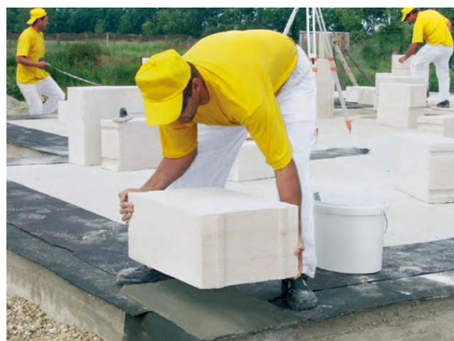
Первым укладывайте блок в самом высоком углу здания, а затем в остальных, ориентируясь на высоту первого. Высоту углов определяйте с помощью нивелира или тахеометра.
