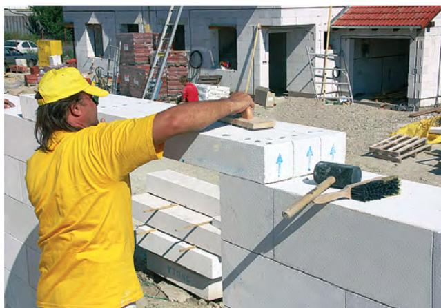
Когда готовая перемычка укладывается на блоки стандартной высоты, то для достижения требуемой высоты кладки следующего ряда может понадобиться выравнивающий слой из обрезанных блоков над перемычкой.
