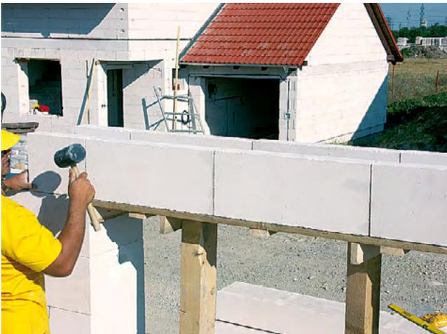
Бетонная балка внутри U-блока должна быть армирована пространственным арматурным каркасом в соответствии с проведённым расчётом или данными таблицы по несущей способности перемычек из U-блоков из «Энциклопедии строительства ISTKULT», выложенной на сайте [istkult.ru](http://istkult.ru). Обычно каркас выполняется из 4–5 прутков рабочей арматуры А400, А500 диаметром 10–12 мм с хомутами А 240 (А-1) диаметром 6 мм, с шагом 100 мм (при перекрытии проёма шириной до 2,5 м).
