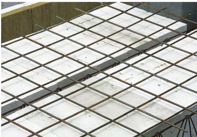
Привяжите сетку к верхней арматуре балок вязальной проволокой. Стыкуйте отдельные сетки между собой с нахлестом величиной не менее 150 мм. При необходимости устанавливайте под сеткой фиксаторы арматуры, чтобы впоследствии сетка полностью оказалась внутри слоя бетона.
