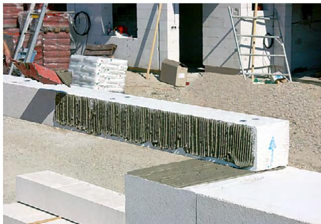
Соединяйте боковые грани перемычек за счёт раствора для тонкошовной кладки. А если при монтаже остаётся пространство между перемычками, заполняйте его монтажной пеной или эластичным утеплителем.
