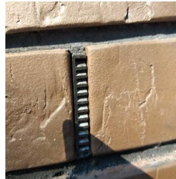
С этой целью у основания облицовочного слоя делается фартук из рубероида на подкладке из цементного раствора, а в самом внешнем слое оставляются отверстия, прикрытые решеткой, через которые вытекает вода. Аналогичные отверстия необходимо оставить у внешнего края стены. Соединение газобетонных блоков и лицевого кирпича производится при помощи специальных связей-анкеров. Элементы крепления должны быть расположены из расчёта 4-8 штук на квадратный метр стены.
