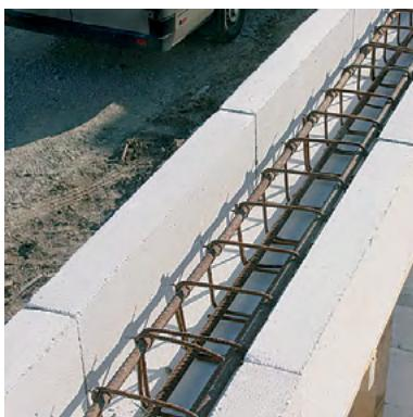
Перемычка из U-образных блоков ISTKULT без дополнительного утепления перед бетонированием
