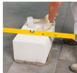
Выравнивание с помощью уровня и резинового молотка
