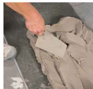
Нанесение первого слоя цементно-песчаного раствора на фундаментное основание
