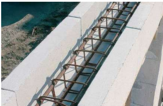
Перемычка из U-образных блоков ISTKULT без дополнительного утепления перед бетонированием
