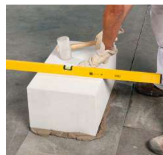
Выравнивание с помощью уровня и резинового молотка
