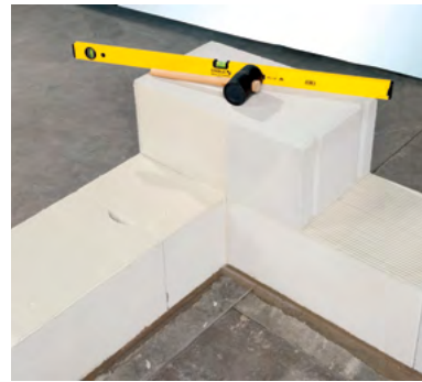
Закладка углового элемента второго ряда
