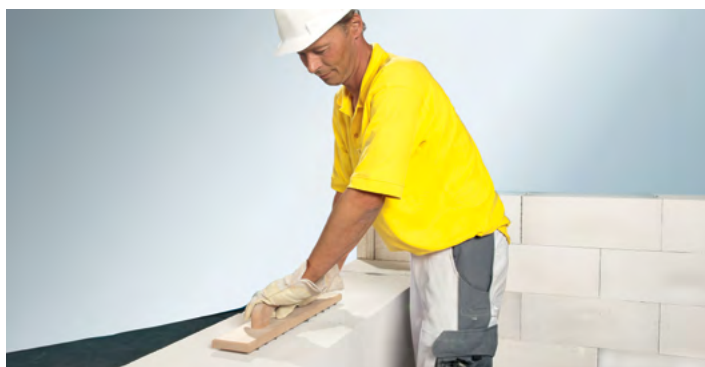
Шлифовка с использованием рубанка
