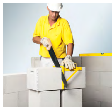
Резка вручную
