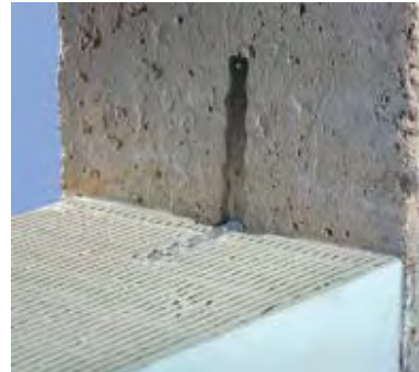
Примыкание к железобетонной колонне
