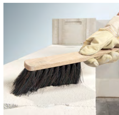
Удаление пыли и загрязнений при помощи щетки
