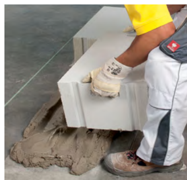
Установка первого ряда блоков
