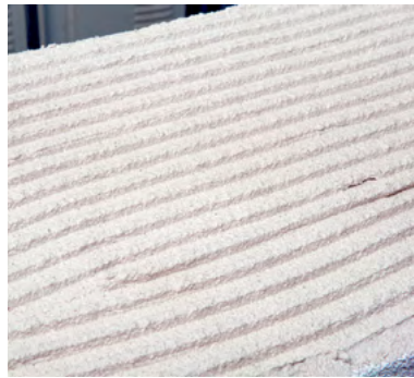
Равномерное нанесение раствора
