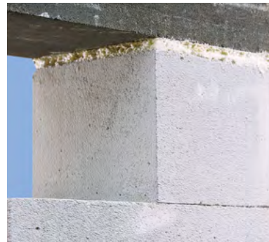
Примыкание к железобетонному ригелю
