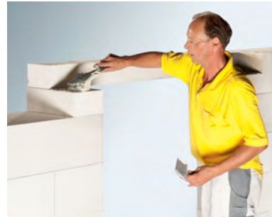
нанесение раствора для тонкошовной кладки ISTKULT
