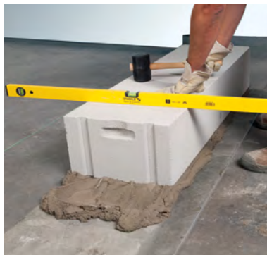
Выравнивание с использованием уровня и резинового молотка
