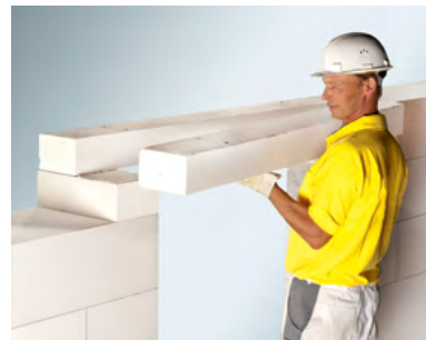
Укладка перемычки ПН125
