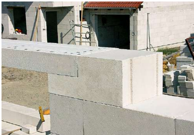
Газобетонные блоки на клею (шов 1-3 мм)
