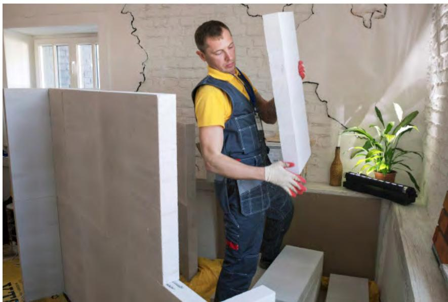
**Ручной монтаж плит ISTKULT Jumbo толщиной 75 и 100 мм**
