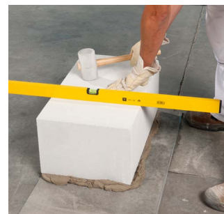
Выравнивание с помощью уровня и резинового молотка
