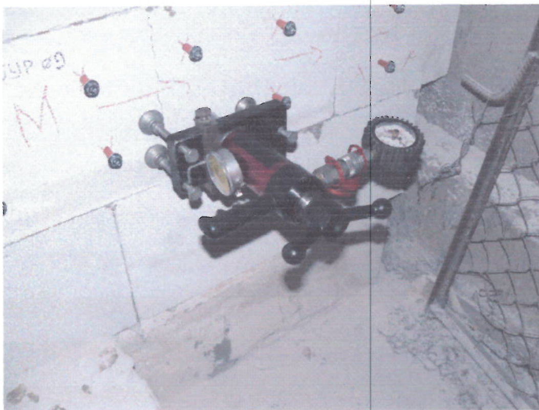
Рис. 3.1 Общий вид домкратной установки для испытаний анкеров на вырыв.
